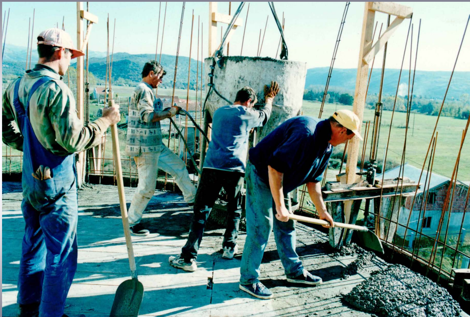
BETONIRANJE U KLIZNOJ OPLATI
