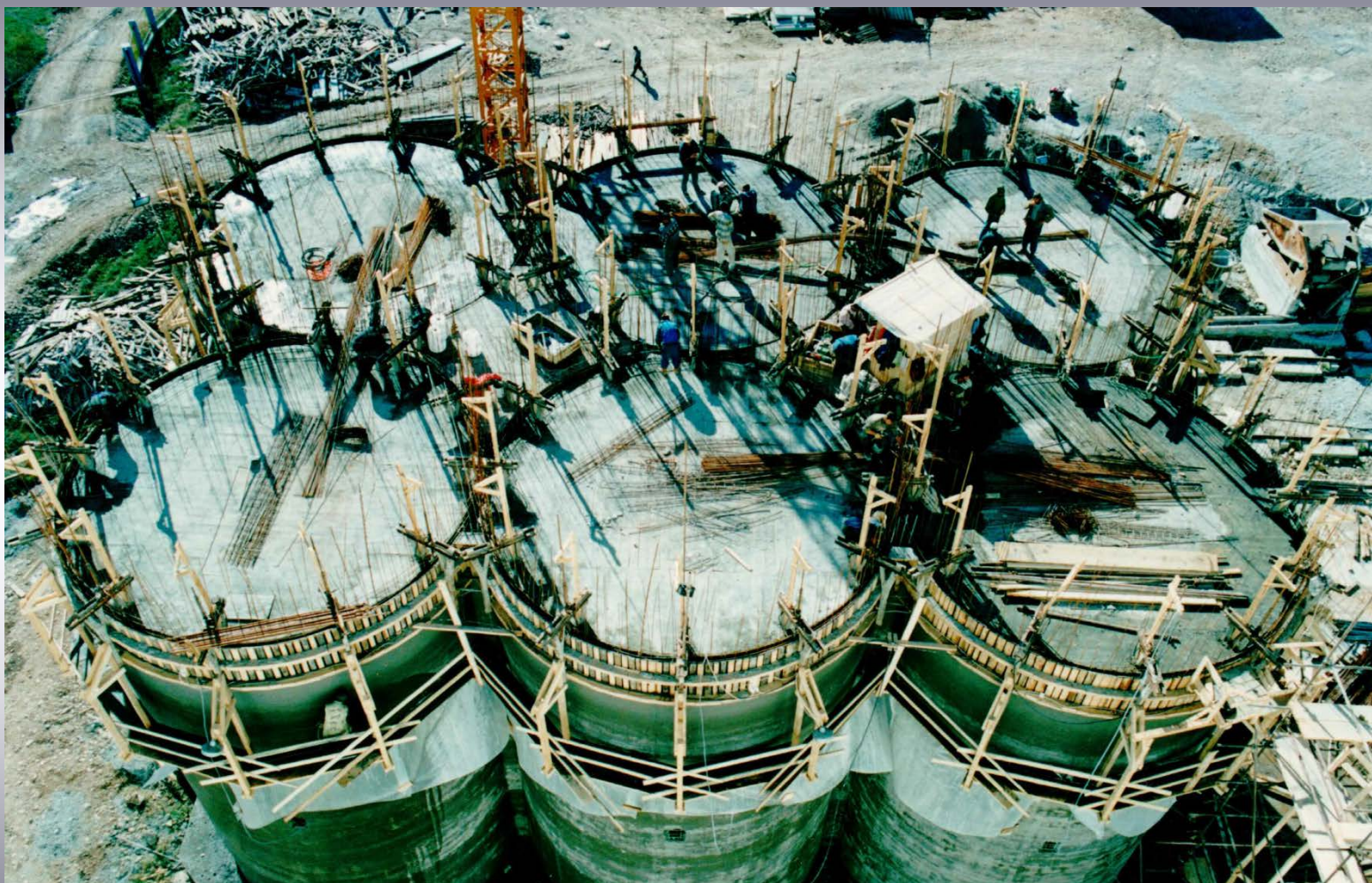
IZGRADNJA ČELIJA U KLIZNOJ OPLATI
